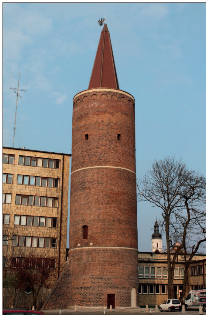
119. Wieża Piastowska po pracach konserwatorskich
