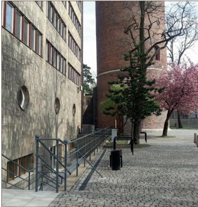
120. Uporządkowane otoczenie wieży wraz z nową aranżacją
