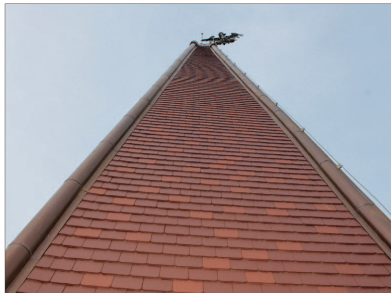
110. Zwieńczenie wieży – ostrostupowy hełm po renowacji
