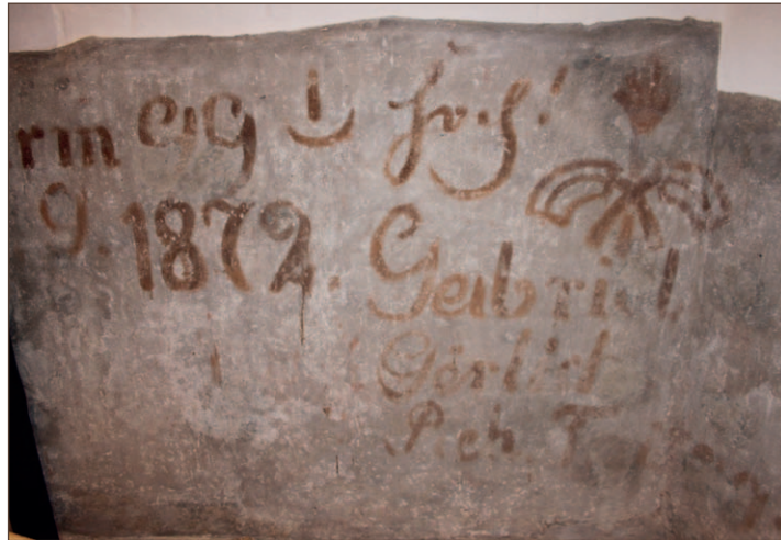
116. Zachowana i poddana konserwacji partia tynków XIX-wiecznych z inskrypcją z epoki
