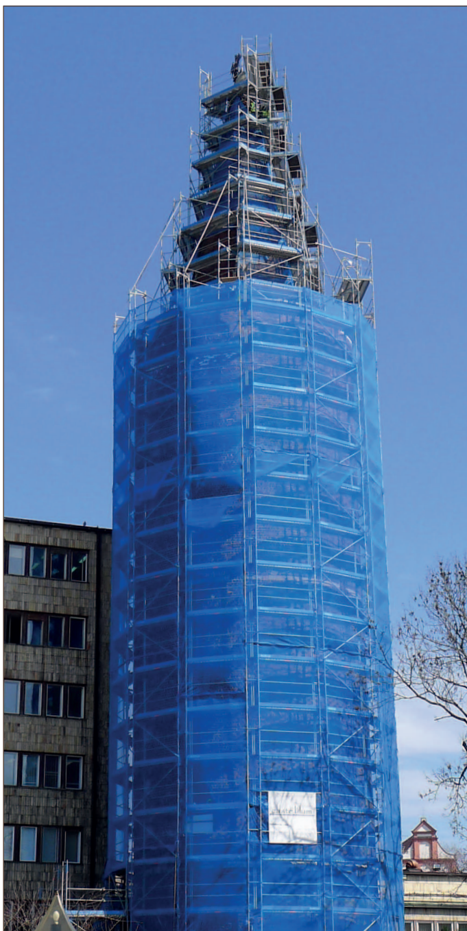
101. Wieża Piastowska w trakcie prac renowacyjnych
