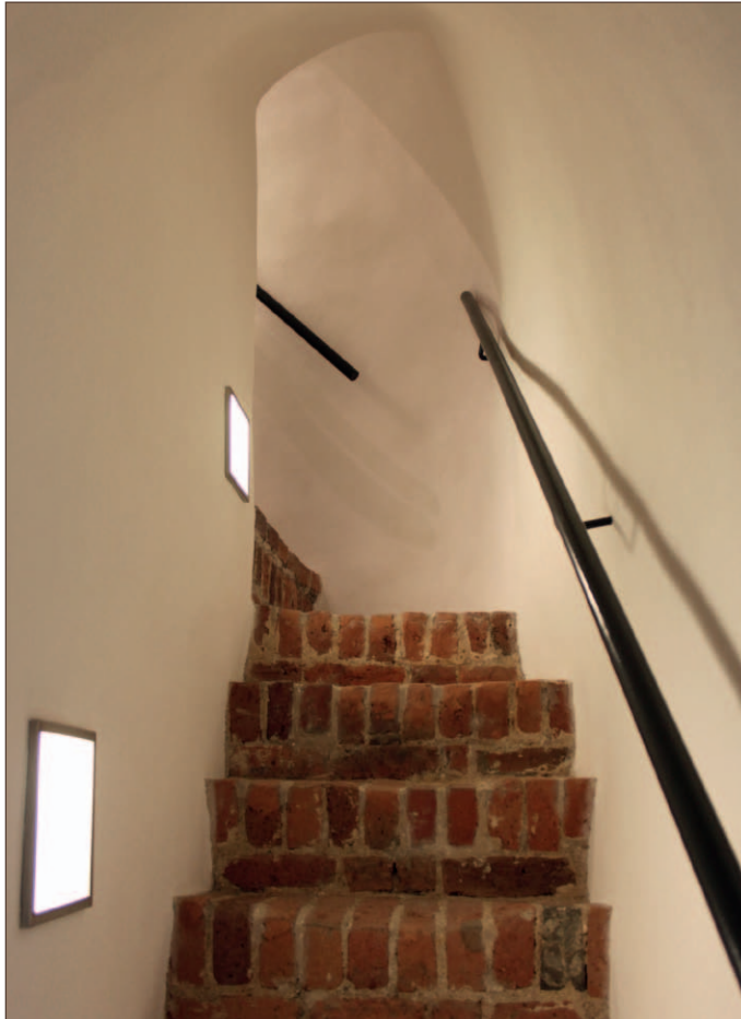
106. Gotycka klatka schodowa w grubości murów po konserwacji
