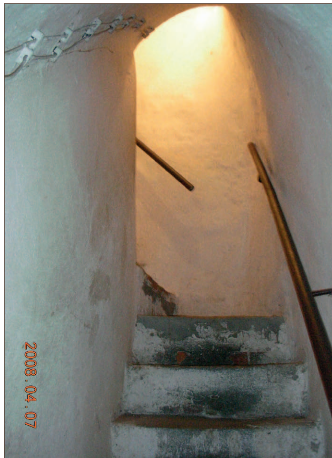
105. Gotycka klatka schodowa w grubości murów przed konserwacją
