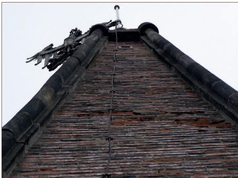
109. Zwieńczenie wieży – ostrostupowy hełm przed renowacją
