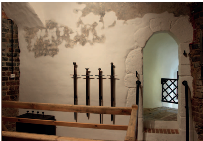
117. Ekspozycja replik białej broni i renesansowy portal kamienny oraz poddana konserwacji partia renesansowych tynków kondygnacji nad lochem głodowym
