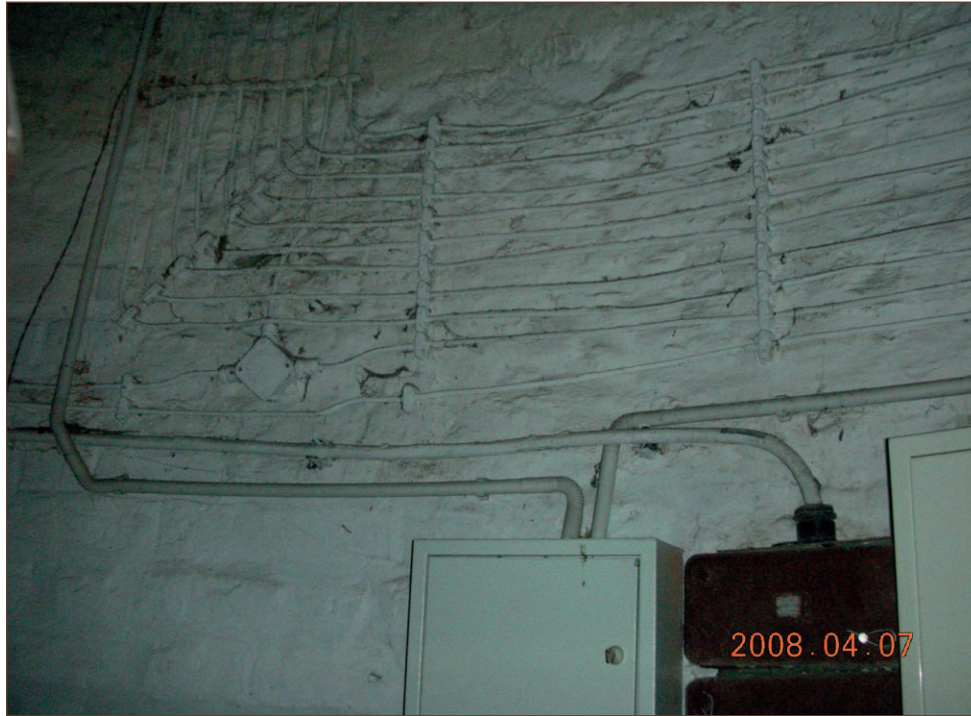
103. Dolny poziom lochu głodowego przed konserwacją
