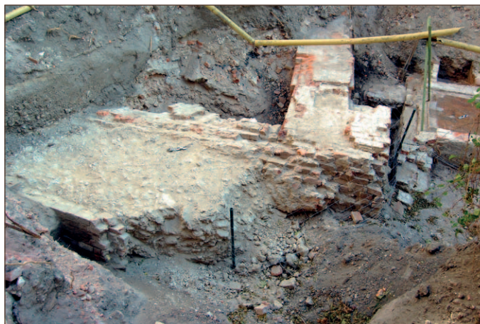
102. Fragment XIII-wiecznego muru obronnego. Z prawej strony – odcinek zachowanego lica wewnętrznego. W środku – grubsze, wymienione lico zewnętrzne z przyporą. Z lewej – przypora gotycka i relikty budynków zamkowych. Badania archeologiczne 2011 r.
