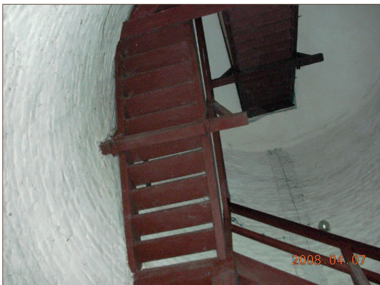
107. Wnętrze lochu głodowego przed konserwacją
