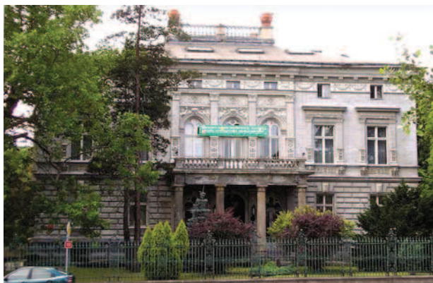
Ryc. 1. Elewacja frontowa przed rozpoczęciem prac, 2007 r. Fot. J. Szot Fig. 1. Front elevation before commencing work, 2007. Photo by J. Szot
