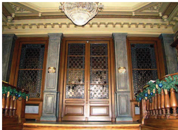
Ryc. 6. Hol wejściowy: stolarka mazerowana, filary z imitacją granitu, witraże, strop sztukatorski po pracach konserwatorskich, 2011 r. Fot. D. Kowalik-Kociszewska Fig. 6. Entrance hall: marbleized joinery, pillars with granite imitation, stained glass, stucco ceiling after conservation work, 2011. Photo by D. Kowalik-Kociszewska
