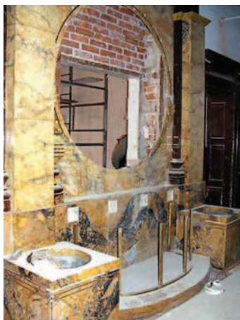
◀ Ryc. 7. Fontanna na I piętrze holu głównego w trakcie prac, 2010 r. Fot. I. Solisz
