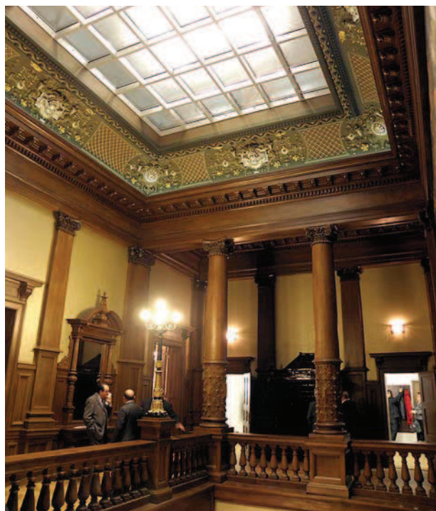
Ryc. 4. Hol I piętra z widokiem na fasadę i świetlik po pracach konserwatorskich, 2011 r. Fot. K. Piecuch Fig. 4. Hall of the 1 st floor with a view onto the bevel and skylight after conservation work, 2011. Photo by K. Piecuch
