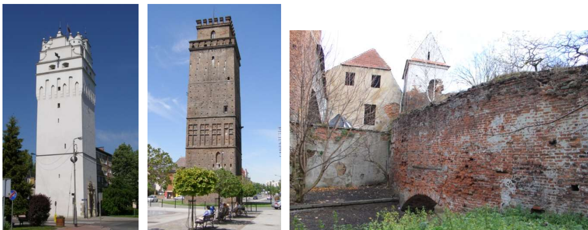
1. Wieża Wrocławska. 2. Wieża Ziębicka. 3. Fragment murów obronnych z przepustem wodnym nad kanałem Bielawki w sąsiedztwie kościoła śś. Piotra i Pawła i Dworu Biskupiego. Fot. I. Solisz.
